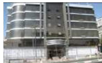
شکل ۴- استفاده از نماهای شیشه‌ای در ساختمان‌ها [۵]
