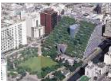
شکل ۳- ساختمان پله ای شکل با درختچه های کاشته شده در نمای آن [۵]
