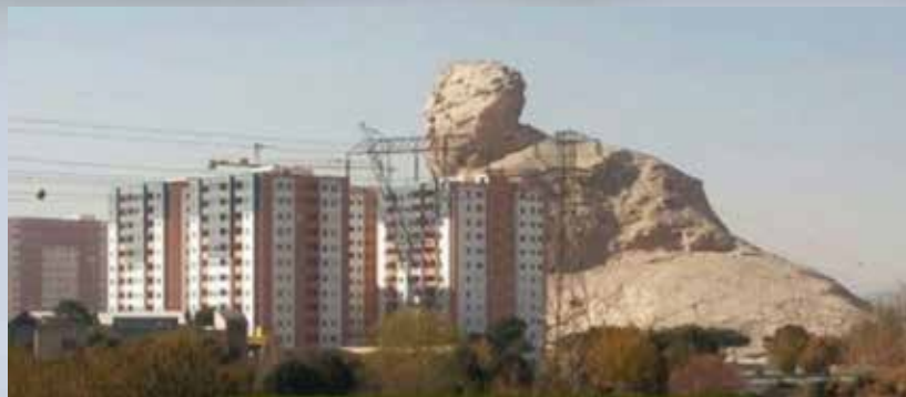
شکل ۲- ساختمانی که با جانمایی نامناسب موجب مخدوش ساختن سیمای یک عنصر طبیعی در شهر شده است. - اصفهان
