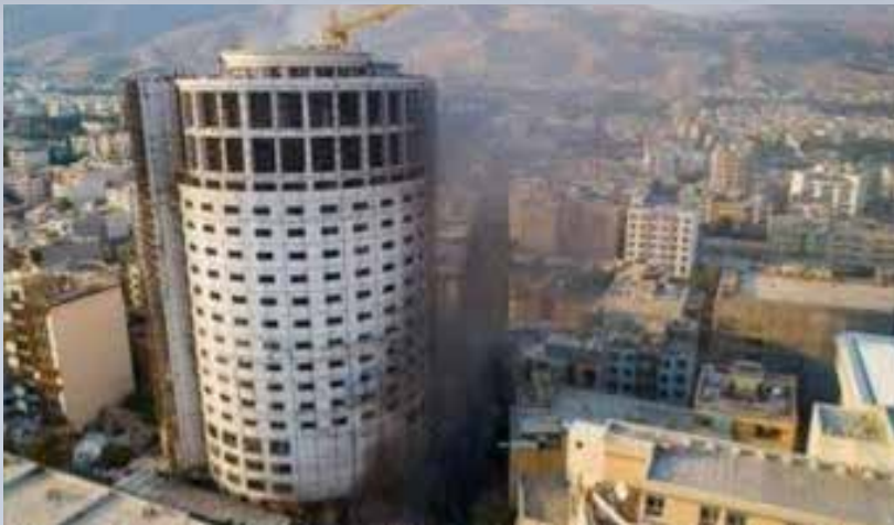
شکل ۳- ساختمانی که هیچ سنخیتی به لحاظ حجمی، ارتفاعی و ... با بافت پیرامونی و ظرفیت ترددی گذرهای مجاور ندارد- شیراز
