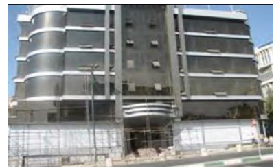
شکل ۴- استفاده از نماهای شیشه‌ای در ساختمان‌ها [۵]
