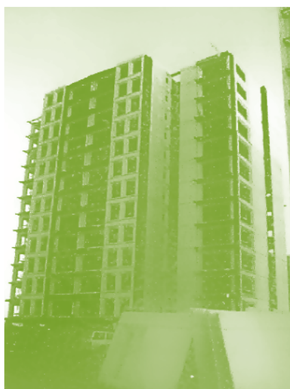
شکل ۱-۱ نمونه‌ای از ساختمان ساخته شده با سیستم سازه‌ای پانل‌های بزرگ تغییر یافته
