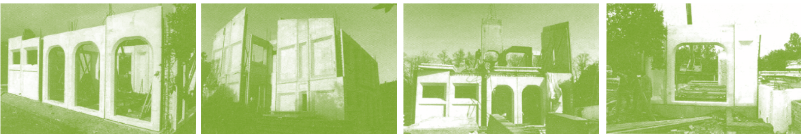
● شکل ۲-۴ پانل‌های دیوار برشی با بازشوهای مختلف
