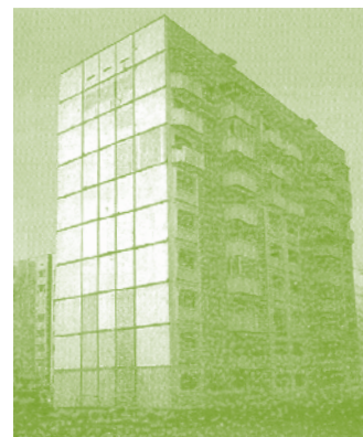
شکل ۵-۱ ▶ ساختمان با سیستم پانل‌های بزرگ پیش‌ساخته در کشور قزاقستان
