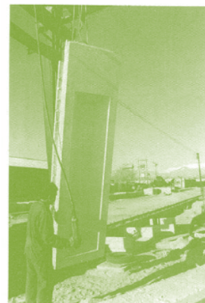
شکل ۳-۲ پانل‌های دیوار برشی به صورت کامل (پر)
