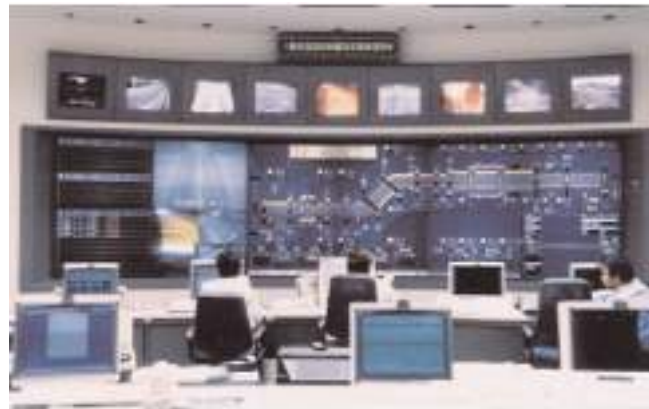
شکل ۱. نمونه‌ی اطاق کنترل و صفحه‌ی نمایش پایش اطلاعات پل Kaikyo در ژاپن [2]
