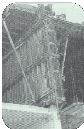
شکل ۲-۸ قالب لبه‌ی دیوار
