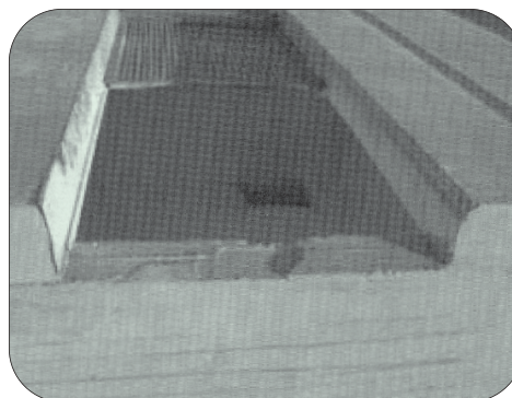
شکل ۹-۱ اجرای سقف با استفاده از پیش‌دالهای نواری دیوار و سقف
