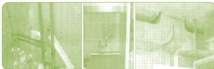
شکل ۴-۶ اجرای تأسیسات مکانیکی
