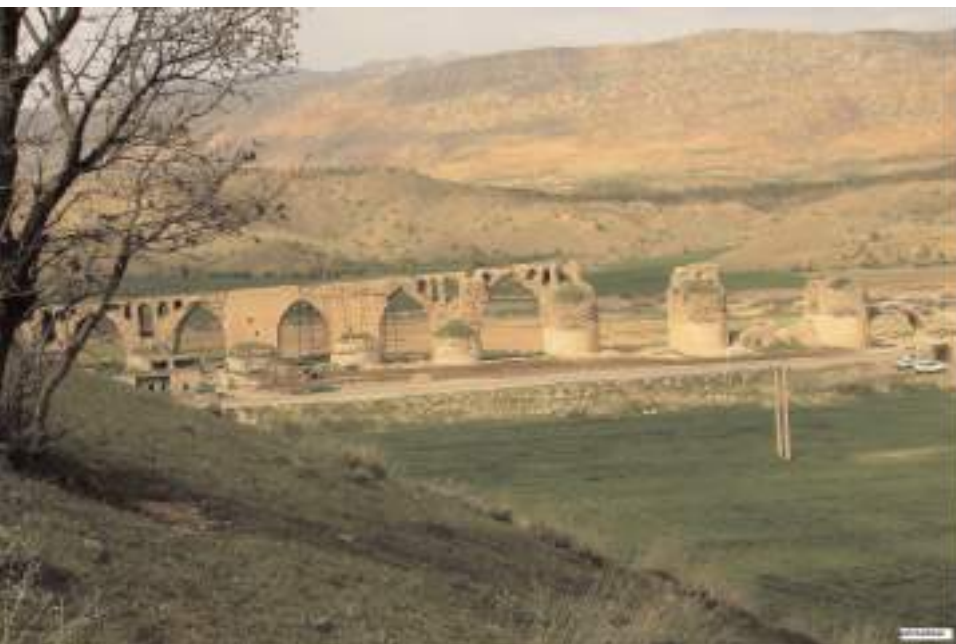
پل تاریخی کلهر - شکل شماره ۵
