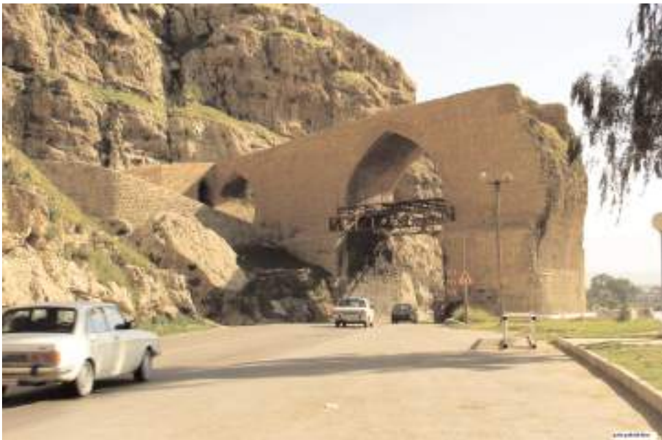
پل تاریخی پل دختر - شکل شماره یک
