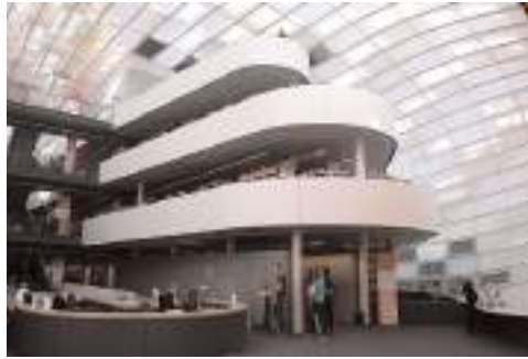
شکل ۴: در داخل کتابخانه هسته‌ی دوقلوی بتنی و کف‌ها به‌عنوان واحدهای غیرفعال ذخیره‌کننده انرژی گرمایی برای کاهش نوسانات دما عمل می‌کنند. لوله‌های ماریپچ کار گذاشته شده داخل کف و سقف‌های بنا بسته به فصل سال آب گرم یا سرد دریافت می‌کنند تا هوای داخل را که از داخل یک باغچه و فضای سبز در قسمت زیرین می‌گذرد گرم و سرد کنند و سپس در سراسر ساختمان منتشر کنند.
