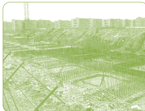
شکل ۱-۴ اجرای شالوده‌ی نواری
