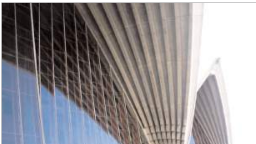
▲ تصویر ۳۴: میله‌های کرومی براق در قسمت خارجی برای نصب شیشه
