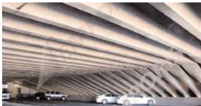
◀◀ تصویر ۳۷: نمونه‌های تیرها با مقطع متغیر (از پیشنهاد اولیه تا نتیجه‌ی نهایی)
