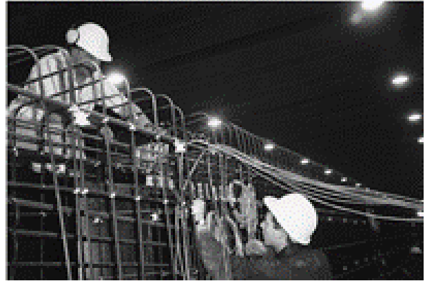
شکل ۲- نمونه‌ای از استفاده فیبر نوری بصورت مدفون در بتن
