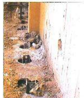
نصب پروفیل ها و بتن ریزی
