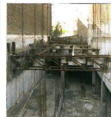
(ب) نمونه ای از مهار متقابل در گودبرداری
