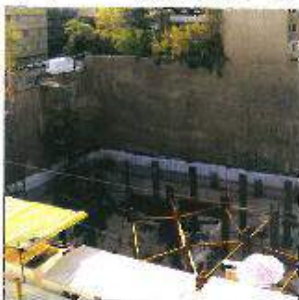
شکل ۲- تصویری از دیواره‌های میخ کوبی شده و مهارگذاری شده همراه با پروریل‌های دول
