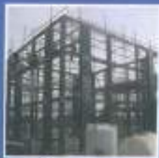
مسجد فرودگاه بین المللی قشم (EPC)
