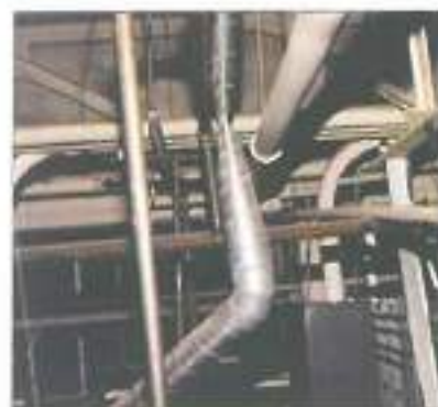
شکل ۳-۲: سازه فولادی در حال اجرا
