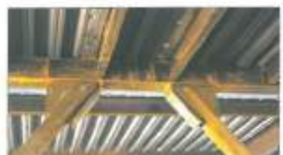
شکل ۳: طراحی مهاربندی جانبی تیر رابط
