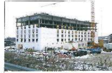
شکل ۵- تصویری از نمای بیرونی ساختمان در حال ساخت با I.C.F
