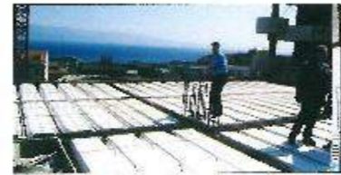
شکل ۳- پانل‌های سقفی هنگام میلگردگذاری
