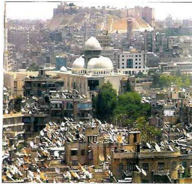
۶- وضعیت ساختمان‌های چندین طبقه در بافت فرسوده شهر حلب
