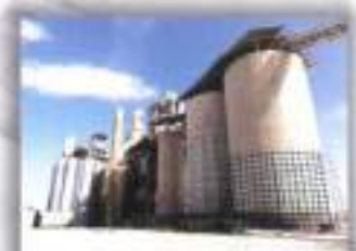
کارخانه سیمان آباد - تقویت ستونها بتنی و سازه های صنعتی با FRP برای افزایش عمر مفید سازه ها
