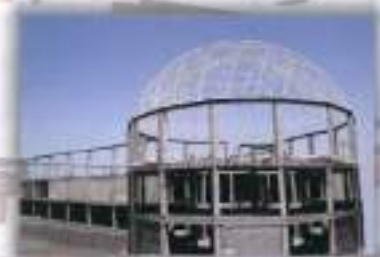
مرکز تجاری گلستان - شهرك مالدان شهر - اردبیل - تقویت سازه بتنی به روش FRP و Steel Jackoting به دلیل تغییر سیستم سقف
