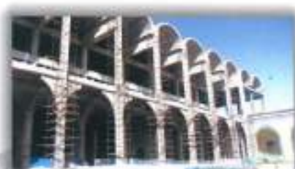
مصلی بزرگ تهران - تقویت سازه های بتنی به روش Steel Jackoting
