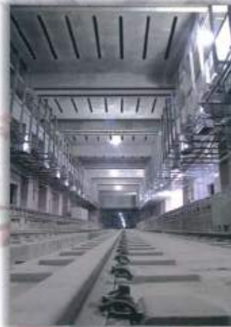
مترو شیراز - تقویت تیرها و دالهای سقف استکله مترو با FRP برای افزایش ظرفیت باربری سقف
