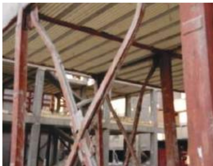
تصویر ۱۶- کماتش مهاربندی به دلیل لاغری مقطع
