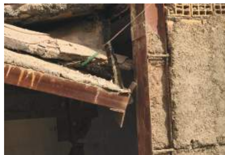
تصویر ۹- جداشدگی اتصال تیر به ستون
