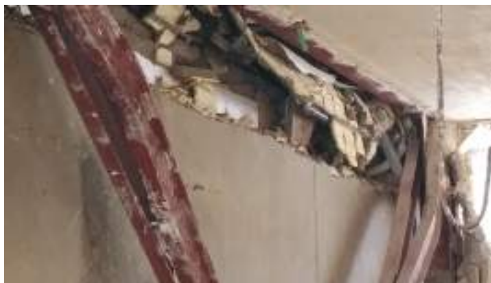
تصویر ۱۹- کمانش بادبندی زوج بین لقمه های فولادی
