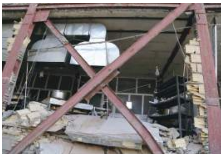
تصویر ۱- کمانش مهاربند به دلیل استفاده از مقاطع I شکل
