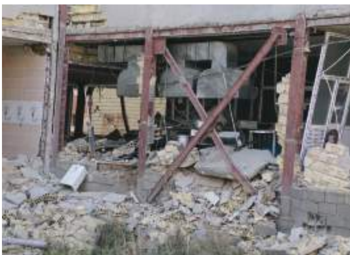
تصویر ۲- کمانش مهاربند به دلیل استفاده از مقاطع I شکل
