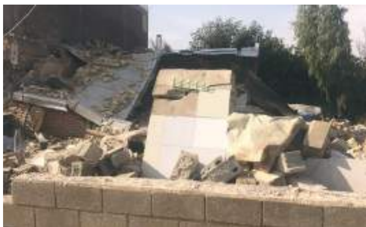
تصویر ۴- آسیب دیدگی کلی سازه مصالح بنایی بدون کلاف
