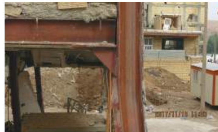
تصویر ۱۰- استفاده از ستون‌های مشبک و تغییر شکل جانبی زیاد
