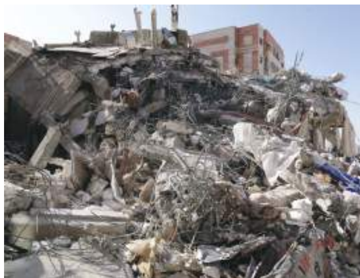
تصویر ۱۸- تخریب سازه بتنی
