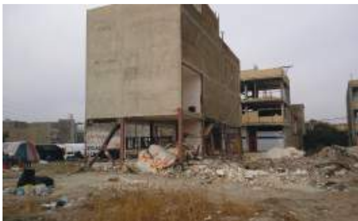
تصویر-۵ اجرای مهاربند در پشت ساختمان
