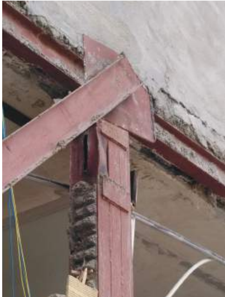
تصویر ۲۰- جداسدگی اتصال ورق بادبندی و ایجاد گسیختگی روی ستون
