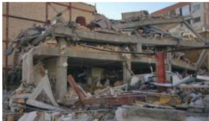
تصویر ۴: فرو ریختن یک سازه بتنی که حتی هنوز به صورت کامل بارگذاری نشده است.
