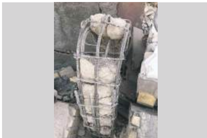
تصویر ۷- خرابی ستون به علت مصالح غیراستاندارد و بی‌کیفیت و عدم رعایت فاصله خاموت
