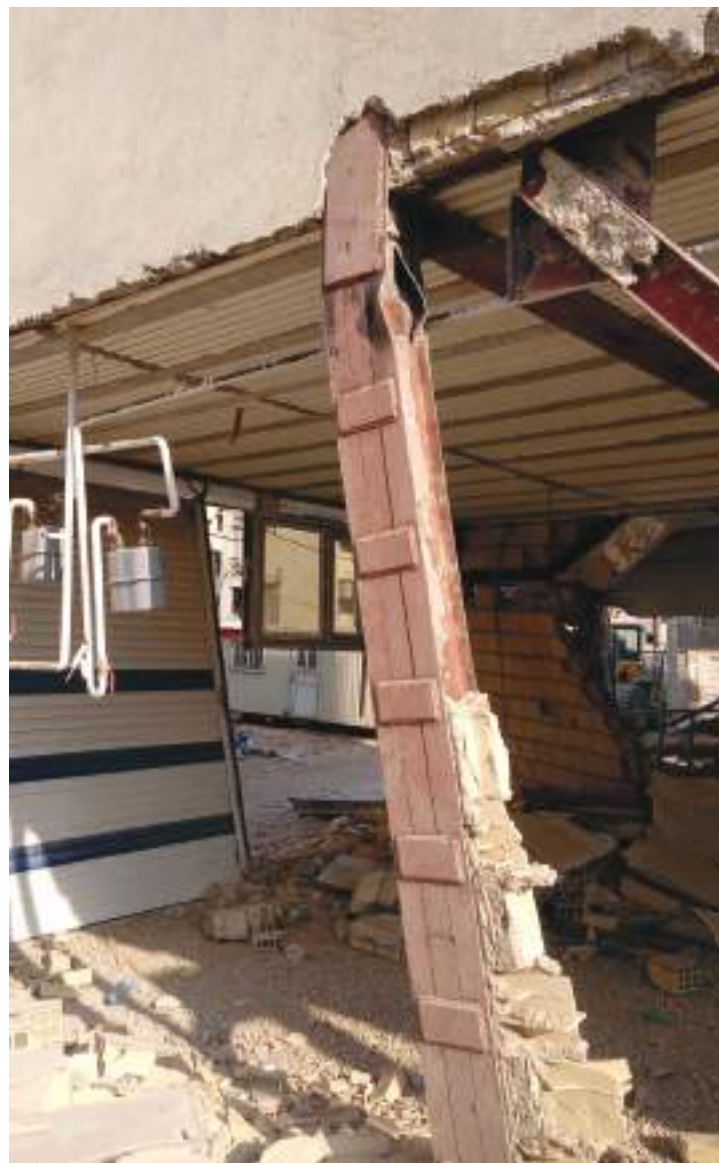
تصویر ۸- پارگی در محل اتصال جان ستون به ورق اتصال
