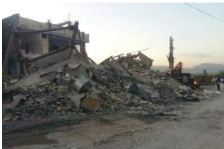
تصویر ۷: پس‌زمینه تصویر سازه فلزی پابرجا، پیش‌زمینه سازه فلزی تخریب شده. تفاوت در بود یا نبود بادبند است.
