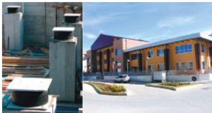
شکل ۲- نمونه جداساز لاستیکی LRB هسته سربی FIP ایتالیا (چپ) مدرسه ای در Bojano ایتالیا، مجهز به جداساز هسته سربی FIP (راست)
