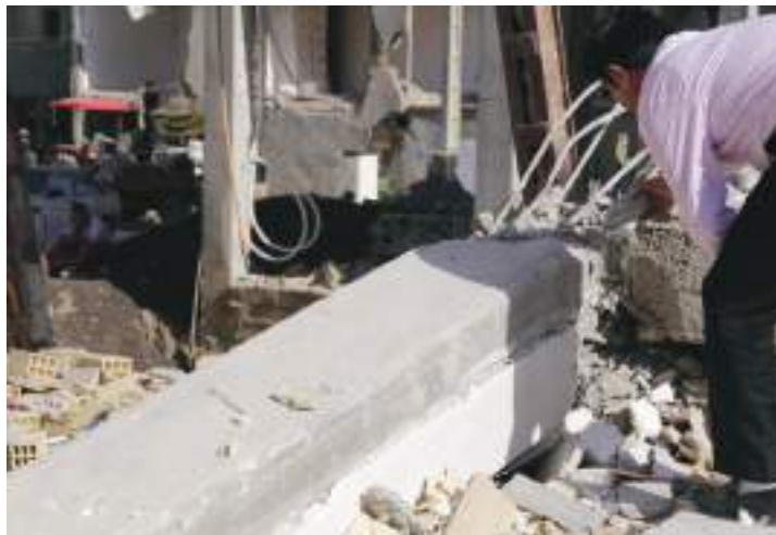
تصویر ۲۵- عدم رعایت طول مهاري و خم مناسب
