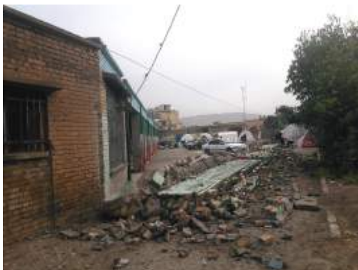
تصویر ۳۶- گسیختگی دیوار محوطه بدون کلاف بندی
