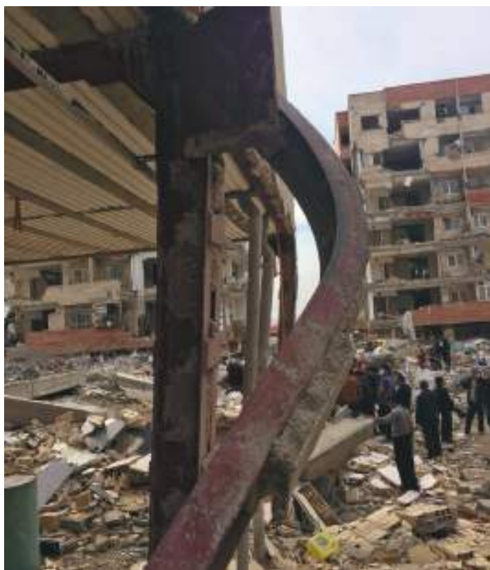
تصویر ۱۷- کمانش برون صفحه بادبندی ها در سازه دارای دو سیستم متفاوت در دو جهت عمود بر هم
