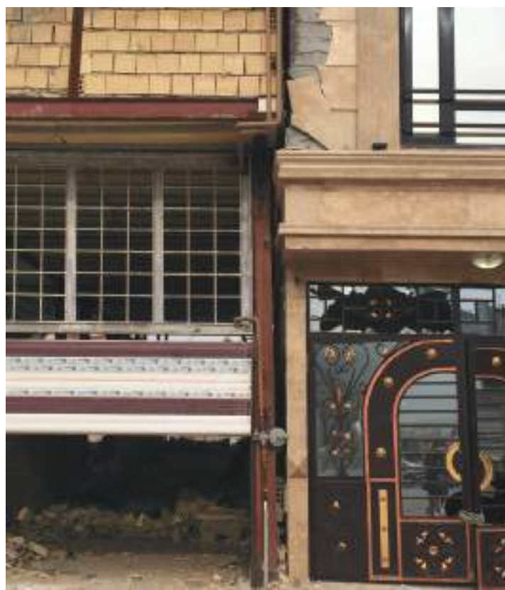
تصویر ۱۴- ضربه زدن دو ساختمان مجاور
