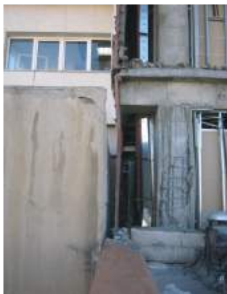
تصویر ۱۰: محل درز انقطاع بین ساختمان جدید و قدیم
