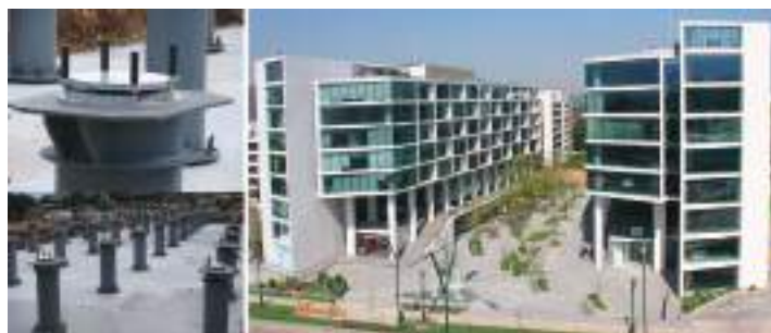
شکل ۳- جداساز پاندول اصطکاکی FIP (چپ) / ساختمان مسکونی در Santiago شیلی، مجهز به جداساز پاندول اصطکاکی FIP (راست)
