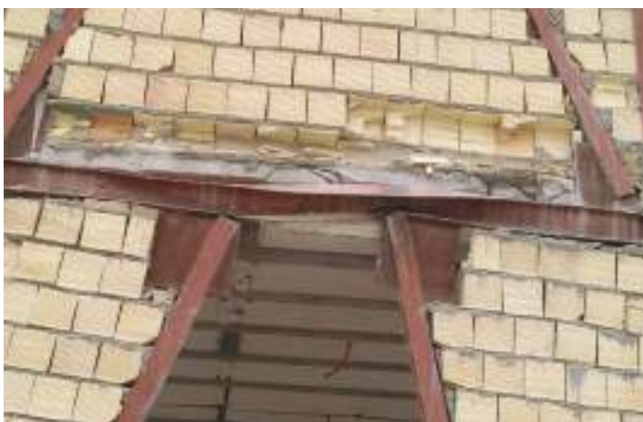
تصویر ۲۳- کماتش جانبی- پیچشی تیر پیوند
