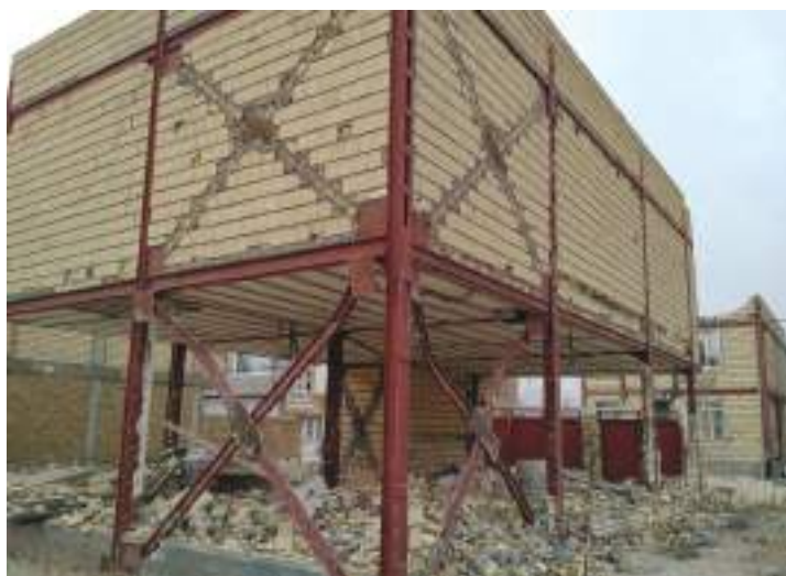
تصویر ۱۸- کمانش بادبندی های فشاری دارای پروفیل تک
