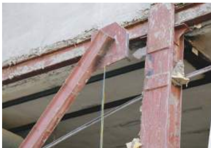
تصویر-۴ مقایسه ابعاد گاست پلیت در مقابل مقطع I متصل به آن
