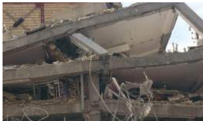
تصویر ۲۵- گسیختگی سازه بتنی از محل اتصالات
