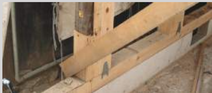
تصویر ۱۵: تعویض قطعات پوسیده با قطعات جدید
