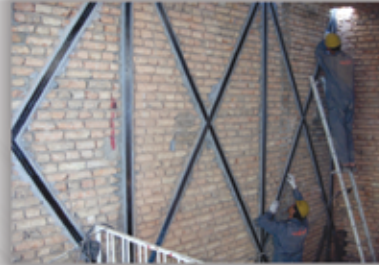
موزه دکتر شریعتی در تهران - بهسازی لرزه ای و تقویت ساختمان اجری با FRP با همکاری شرکتهای SMTeam و EMPA (سونیس)
