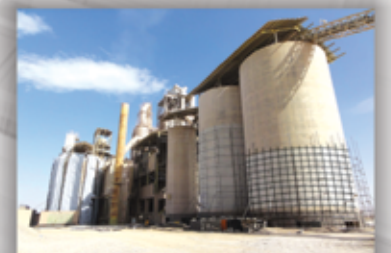
کارخانه سیمان آباد - تقویت سیلوهای بتنی و سازه های صنعتی با FRP برای افزایش عمر مفید سازه ها
