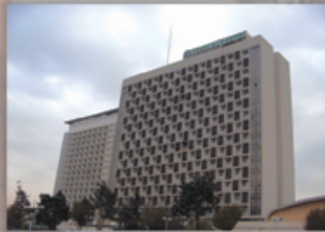
هتل بزرگ استقلال تهران برجهای شرقی و غربی - طرح بهسازی لرزه ای با همکاری شرکتهای SMTEAM و EMPA (سونیس)
