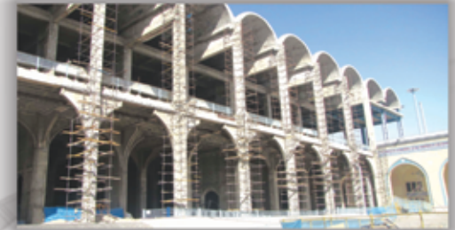
مصلی بزرگ تهران تقویت سازه های بتنی به روش Steel Jacketing
