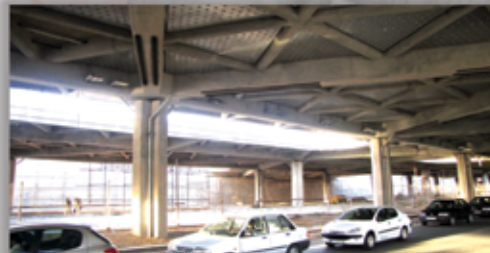
پل قم رود - قم - تقویت تیرهای بتنی با FRP Laminate
