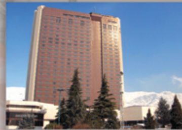
هتل بزرگ آزادی تهران - بهسازی لرزه ای ساختمان ۲۸ طبقه بتنی تقویت ستونها با FRP و استفاده از میراگرهای هیدرولیک با همکاری شرکتهای SMTeam و EMPA (سونیس)
