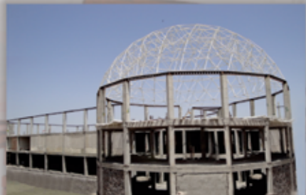
مرکز تجاری گلستان - شهرک مکانشهر - اردبیل تقویت سازه بتنی به روش Steel Jacketing و FRP به دلیل تغییر سیستم سقف
