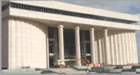
مجتمع تجاری خلیج فارس - شیراز - تقویت موضعی تعدادی از تیرها و ستونها با FRP به دلیل تغییر کاربری
