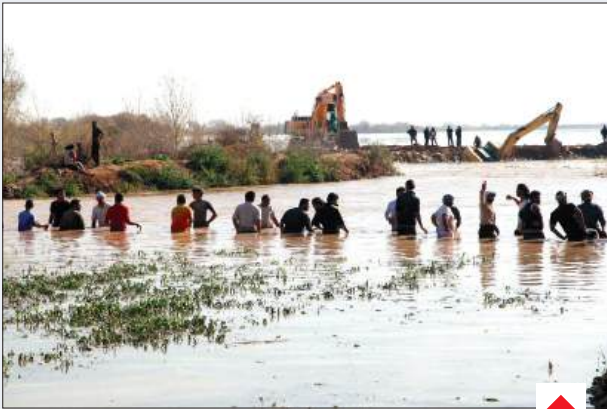
عملیات ترمیم سیل بند در خوزستان - عکس کوروش سنایی
