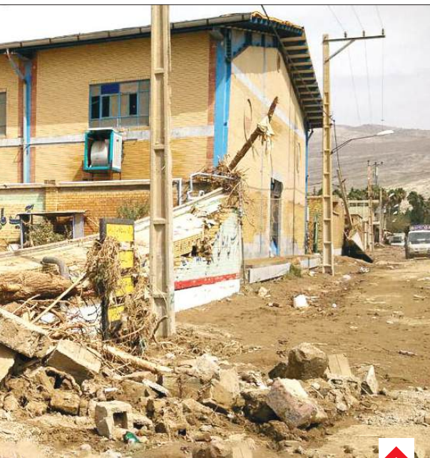
آثار خرابی سیل پل دختر- منبع: پایگاه خبری شفقنا
