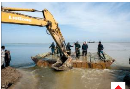
احداث پل شناور در جاده خواجه نفس به گمیشان جهت هدایت سیل به سمت دریا (۱۳۹۸/۱/۴)
